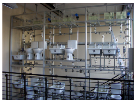
Betriebsbereit aufgebaute Demonstrationsanlage
