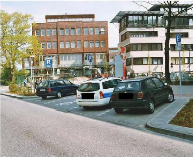
Abb. 3.5 Schrägaufstellung für Pkw im Heegbarg
