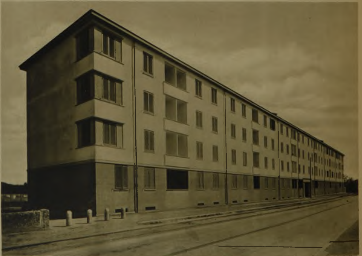
Kleinwohnungsblock in Mailand ARCHITEKT ENRICO A. GRIFFINI
