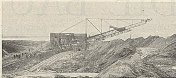
Abb. 4. Ausbruch vom Dammschütter abgesetzten flüssigen Bodens.
