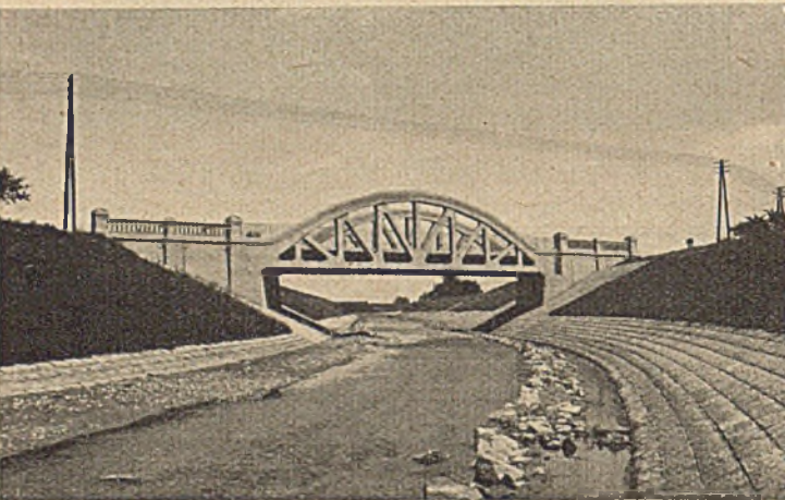
Abb. 2. Bundesstraßenbrücke über die große Tulln in Absetten; Stützweite 24,40 m, Fahrbahnbreite 8,50 m; Belastung 18 t-Dampfwalzen, Wagenzüge von 12 t und Menschengedränge von 460 kg/m 2 . Als bewegliche Lager kamen Stahlgußpendel zur Verwendung.
