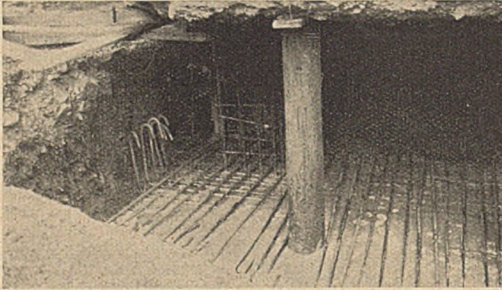
Abb. 9. Ausführung der Unterfangung am 65 m hohen Schornstein.
