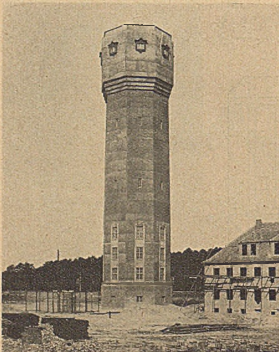
Abb. 8. Wasserturm in Neuseddin.
