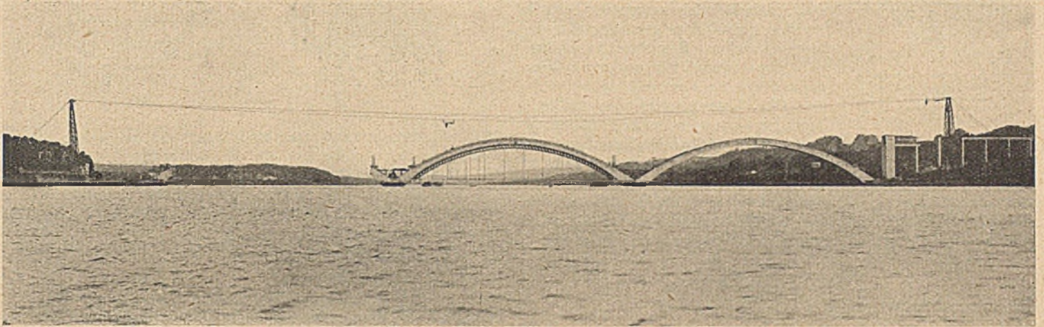
Abb. 4. Bauzustand Ende des Jahres 1928.
