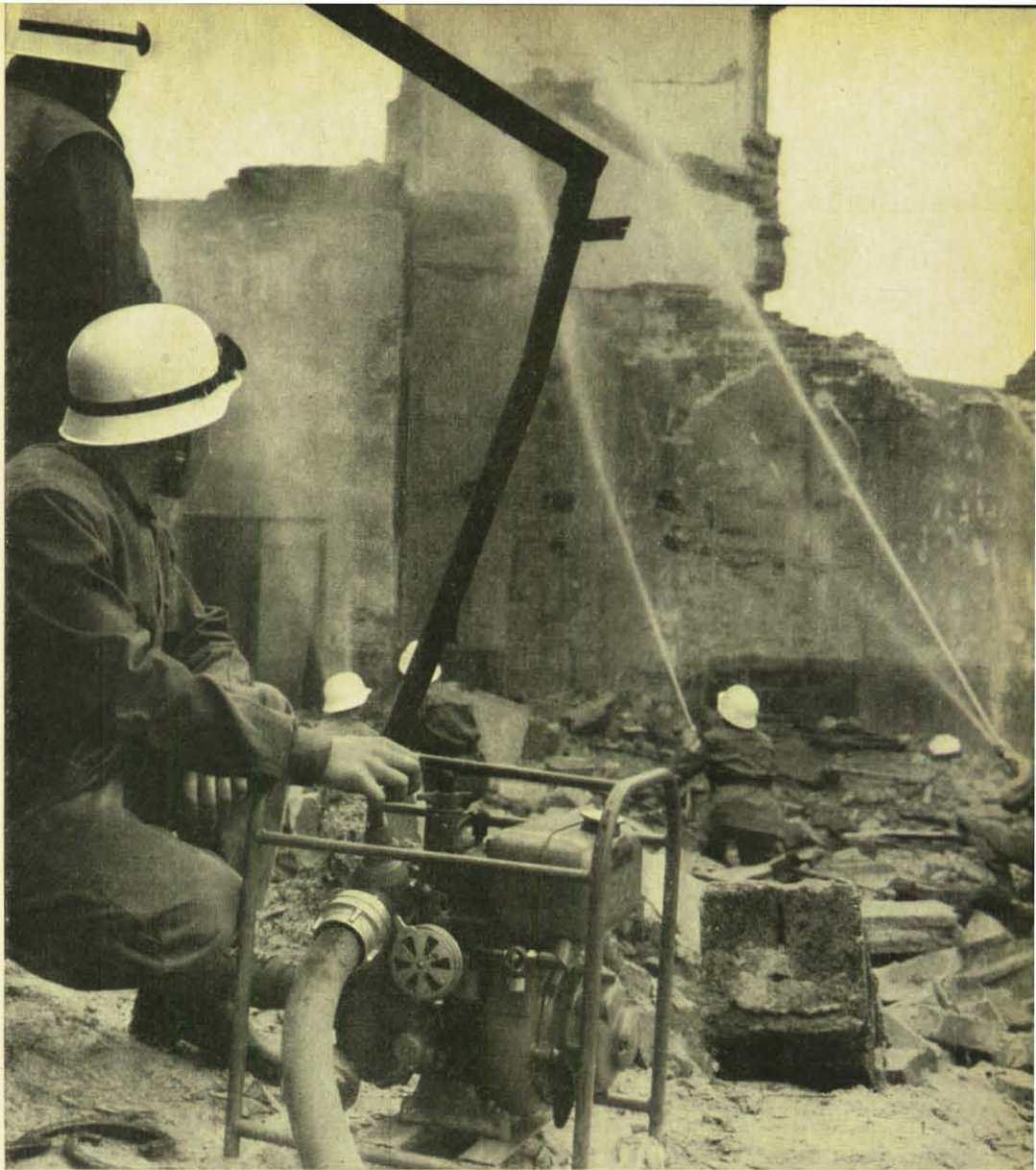
Hier können in geradezu idealer Weise Rettungs- und Brandschutzübungen durchgeführt werden. Das obige Bild demonstriert Wurfweite und Wurfhöhe der TS 2/5, einer tragbaren Kraftspritze, mit der die Kräfte des Selbstschutzes der Bevölkerung ausgerüstet werden sollen.
