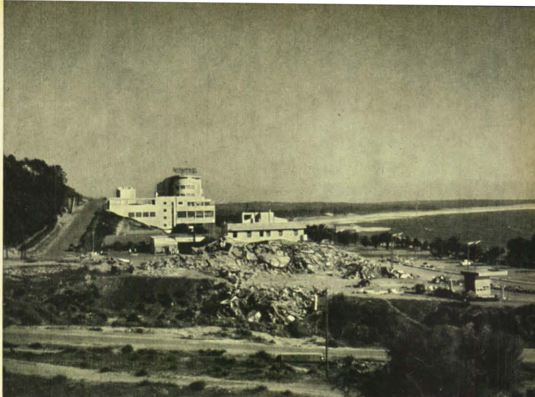
Nach der Katastrophe: Vor dem stehengebliebenen eingeschossigen Haus liegt der Trümmerkegel des total zusammengebrochenen siebenstöckigen Wohngebäudes, das unser Foto auf der vorigen Seite vor dem Erdbeben zeigt. Im Hintergrund das Touristen-Hotel Mauretania.
