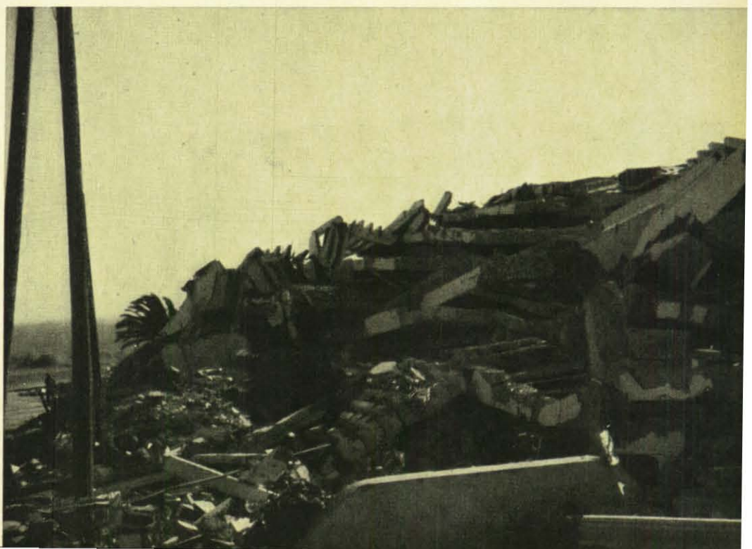
Ein Bild der perfekten Zerstörung: Die Überreste des Wohnhauses, aus der Nähe gesehen. Deutlich ist die Lage der Decken, die hier einen „Blättertort“ bilden, zu erkennen. Ein furchtbarer Anblick der Verwüstung, wie er sich den Helfern von Agadir auf Schritt und Tritt bot.
