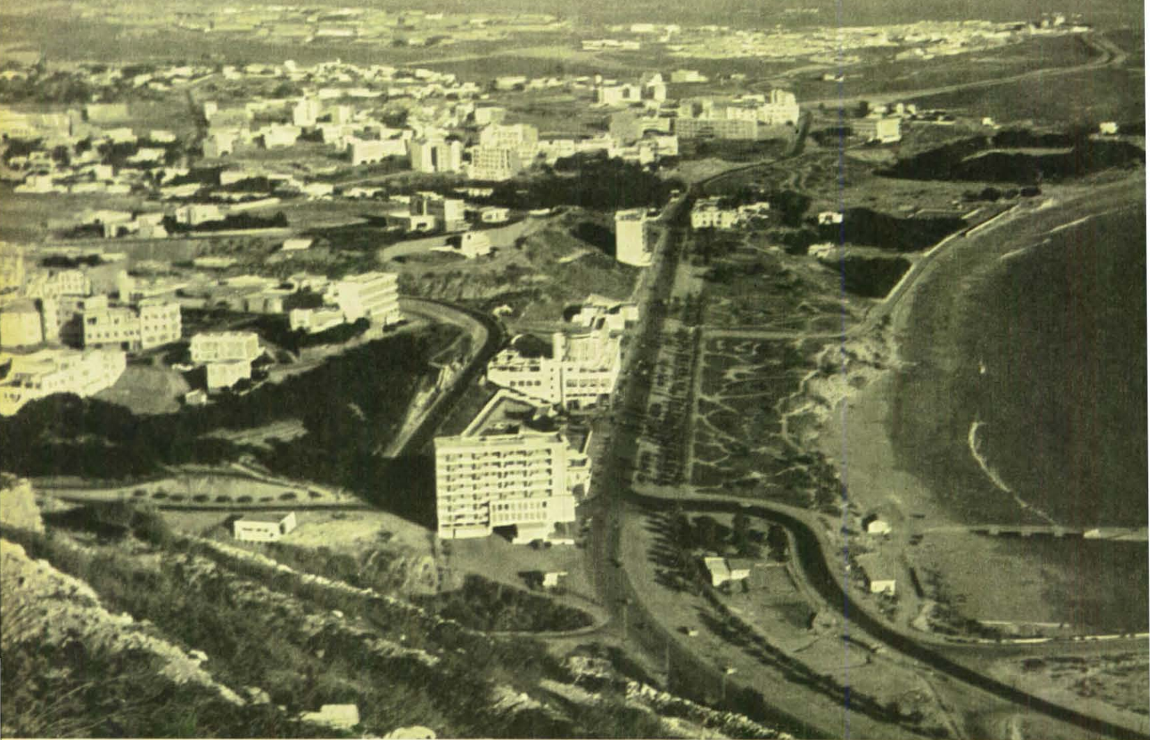
Diese Aufnahme, von der Burg von Agadir aus gemacht, zeigt das moderne Europäerviertel vor dem Erdbeben. Im Vordergrund ein siebengeschossiges 42-Familien-Wohnhaus. Wie das Gebäude nach der Katastrophe aussah, zeigen unsere beiden Fotos auf der nächsten Seite.
