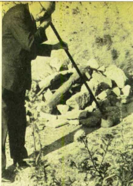
Rechts: Eine Horchsonde „Marke Eigenbau“ bewies bei der Bestimmung des Standortes Verschütteter ihre Brauchbarkeit.
