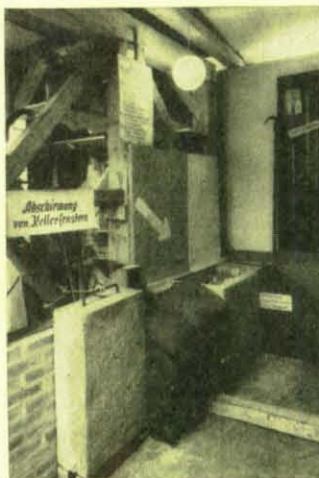
Der Stand des BLSV auf dem Nord- deutschen Baumarkt zeigte u. a. verschiedene Möglichkeiten, wie man über Erdgleiche liegende Kellerfenster abschirmen kann.
