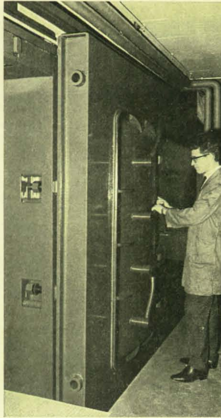
Größere Schutzanlagen, wie z. B. Mehrzweckanlagen oder Bunker, brauchen breitere Eingangstüren, um einen schnellen Einschleusvorgang zu ermöglichen.
