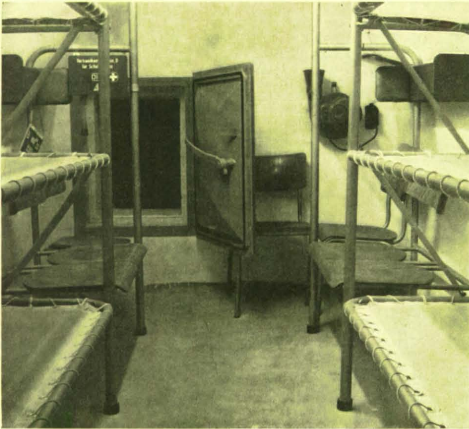
Die Anforderungen an die innere Abschlußklappe eines Notausstiegs sind die gleichen wie bei gasdichten Abschlußtüren. Man begnügt sich jedoch mit kleineren Maßen, da
