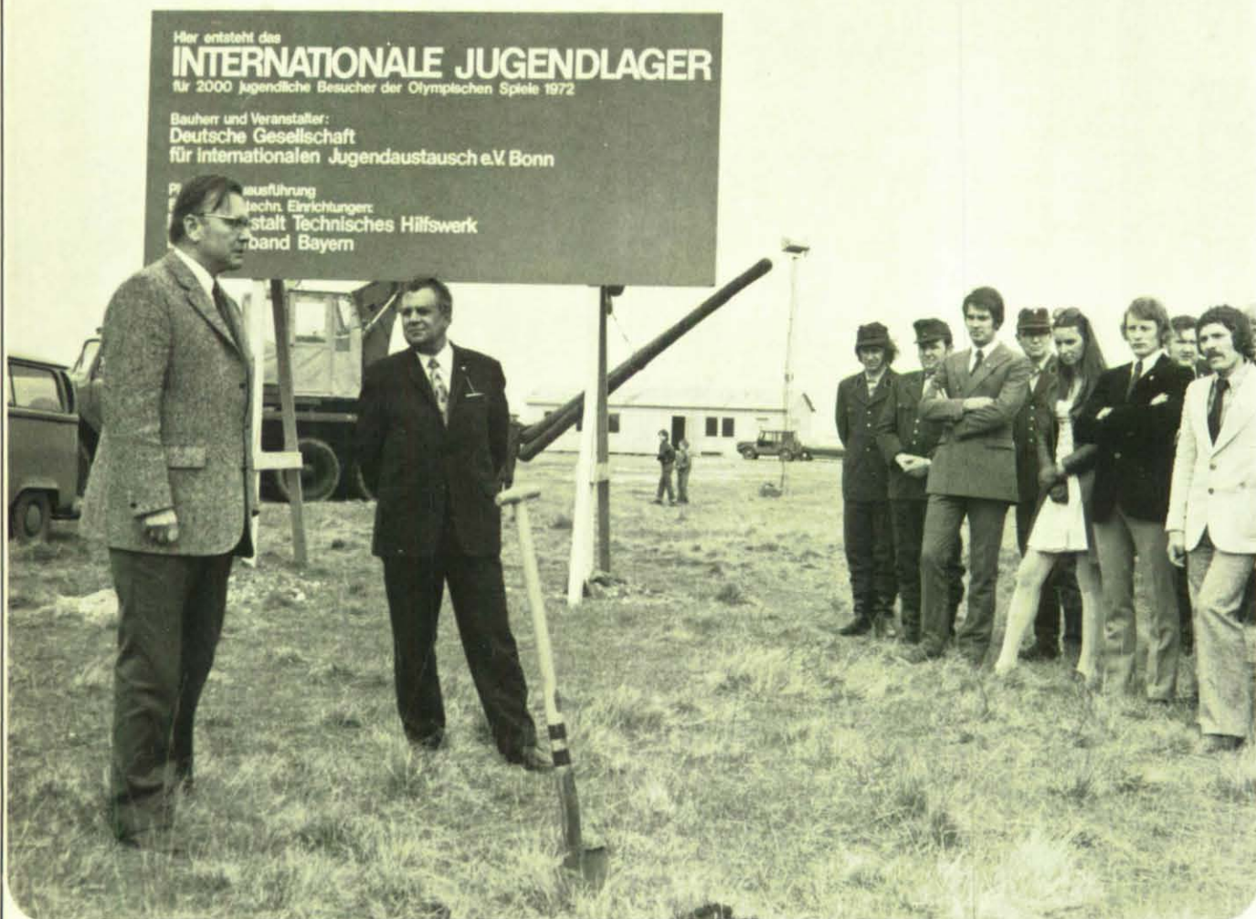
Spatenstich für das Jugendlager. Links: THW-Landesbeauftragter Dipl.-Ing. Schwarz; neben ihm Vizepräsident Buchstaller von der Gesellschaft für internationalen Jugendaustausch.
