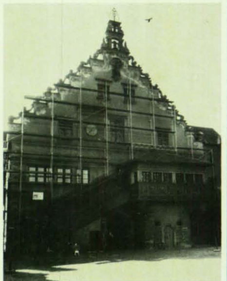
Der THW-Ortsverband hatte die Einrüstung des Rathauses übernommen.
