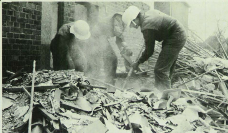
THW-Helfer des OV Warendorf beim Schutträumen nach dem Hausabbruch.
