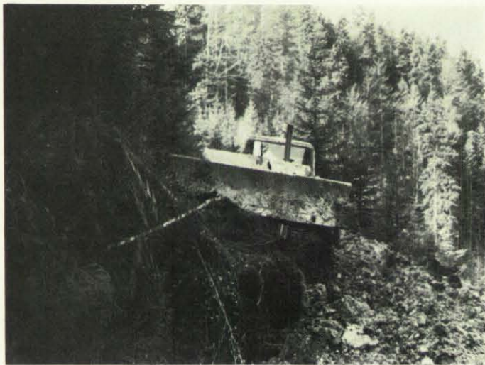
Soweit es die Bodenverhältnisse zuließen, wurden Planierdrapen zur Räumung eingesetzt.
