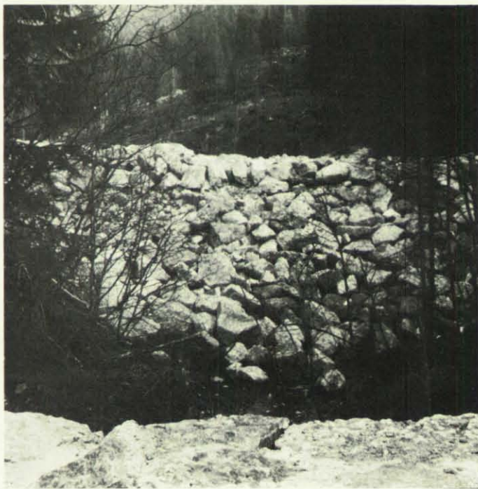
Blick vom Steindamm II über die erste Murfangsperrn zum Rutschhang.
