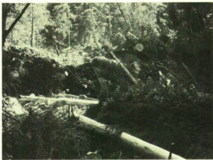
Unter schwierigsten Arbeitsbedingungen wurden die Bäume im gefährdeten Teil des Hanges gefällt und geborgen.
