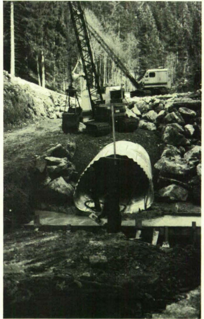
Das Foto zeigt, wie der mehr als mannshohe Durchlaß zugebaut wird.
