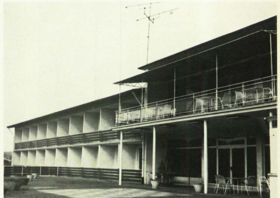
Die neue Unterkunft der BVS-Bundesschule im Hotel „Haus Aggertal“.
