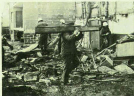
Über 100 Jahre alt war dieses Fachwerkhaus, das die THW-Helfer aus Wickede abrissen.
