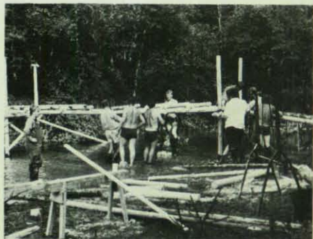
Arbeitsbeginn am Fußgängersteg.
