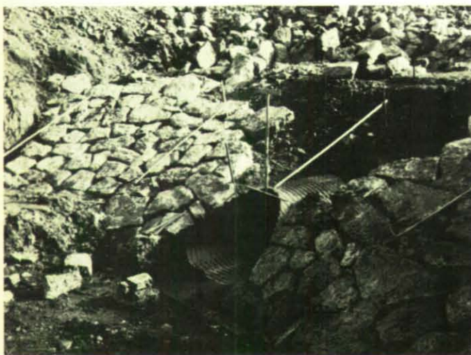
Mit schweren Felsbrocken wird der Damm befestigt.
