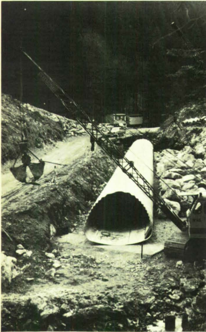
Unmittelbar im Bett des Wildbaches wird das erste Armco-Thyssen-Rohr eingebaut.
