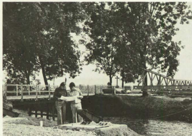
Baudirektor Schwarz und THW-Ortsbeauf- tragter Schmidt über- prüfen die Baupläne – vom anderen Ufer her wächst die Brücke über die Aitrach.
