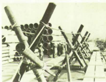
Teilansicht des fertigen Chinasteges. Die Handleinen am Mittelteil des Steges dienen der Sicherheit der Benutzer.
