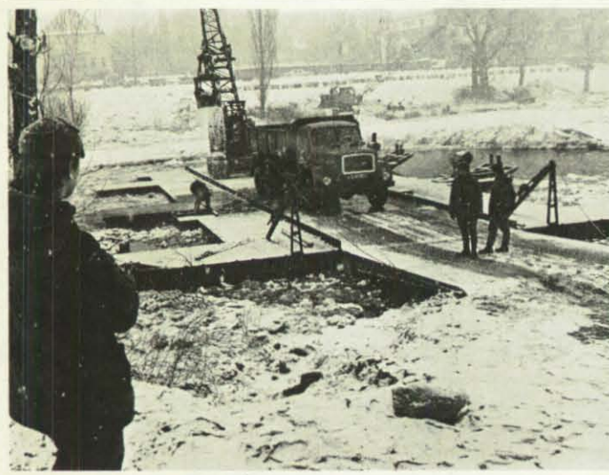
Mit Hilfe einer Pontonbrücke wurde auf der Aller bei Celle ein rund 15 000 cbm großer Eisklotz mit Baggern soweit abgetragen, daß der Wasserabfluß nicht mehr gehemmt und somit die Gefahr einer Überschwemmung gebannt war.
