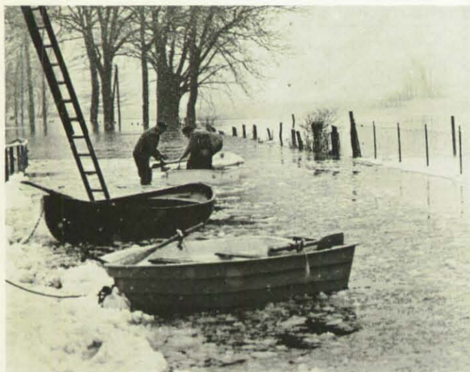
Vielorts kam es durch eine mittelstarke Sturmflut zu Überschwemmungen, wie hier im Deichvorland an der Elbe in Bleckede.
