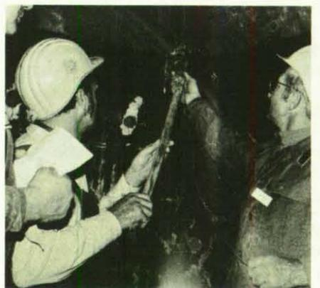
In einer unterirdischen Kammer werden die Sprengsätze eingeschoben.
