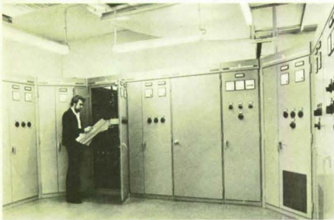
In speziellen Transformator- und Gleichrichteranlagen werden die von den Versorgungsunternehmen angebotenen Versorgungsspannungen auf die benötigten Spannungsarten und Spannungshöhen umgesetzt.
