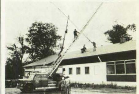
Mit Hilfe der Feuertreileiter wurde der große Antennenmast aufgestellt.
