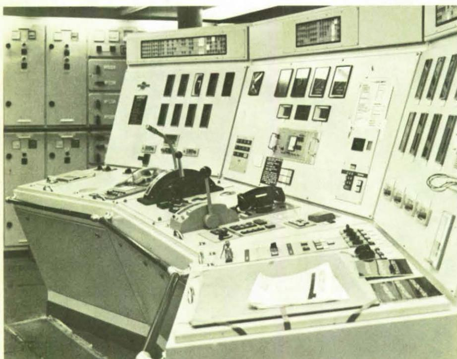
Maschinenkontrollraum. Knopfdrucktechnik und elektronische Steuerung prägen das Gesicht des Maschinenkontrollraumes, wo die Anzeigen vieler Brandschutzanlagen zusammenlaufen. Der Raum selbst ist ebenfalls brandgeschützt.
