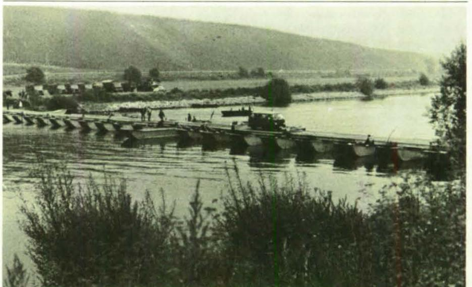
Über die aus sechs Fähren bestehende Brücke rollt das erste Fahrzeug.
