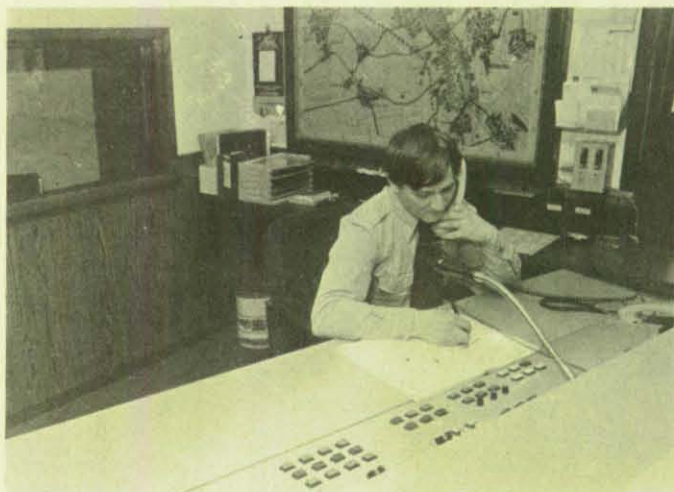
Die Leitstelle mit Funkanlagen, Wechselsprecheinrichtung und allen anderen Steuerungen wurde selbst geplant und ausgeführt.
