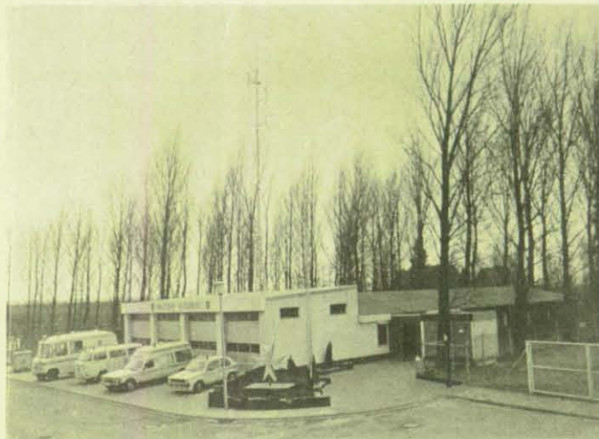
Die neue Dienststelle des MHD Bedburg: Auch das zwölf Zentner schwere Malteser-Kreuz im Vordergrund sowie der fast 20 m hohe Funkmast wurden in Eigenleistung gebaut.
