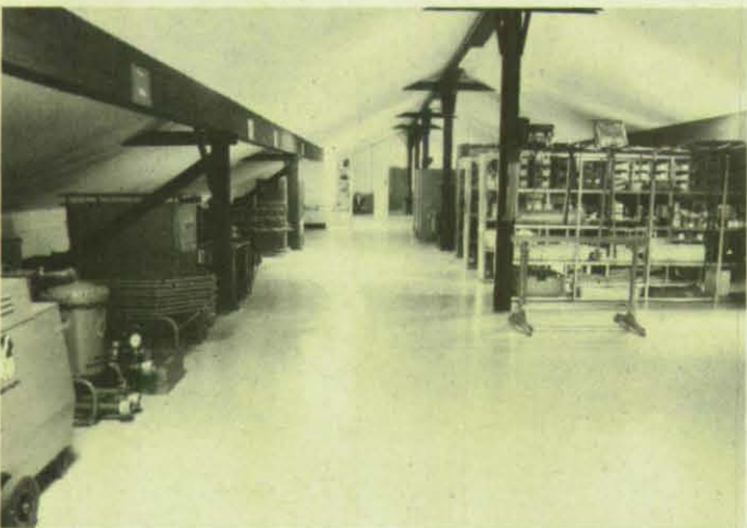
Das Hauptlager über der Kfz-Halle.
