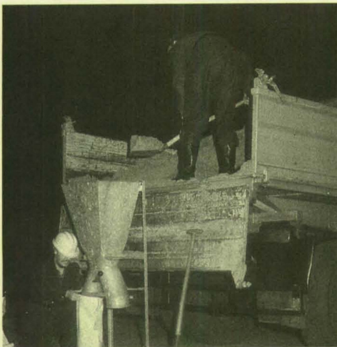
Über einen Trichter werden die Sandsäcke gefüllt.
