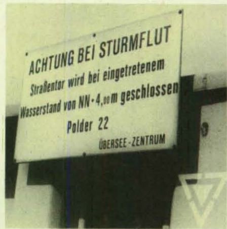
Hinweise an den Polderwänden, daß bei einem Wasserstand von 4 m über NN die Tore geschlossen werden.
