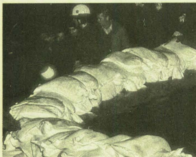
Der Aufbau der Sandsäcke muß fachmännisch erfolgen und wird deshalb oft geübt.
