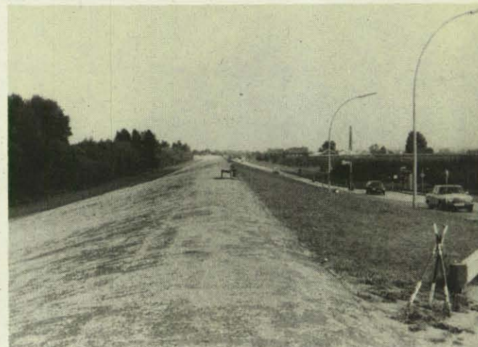
Ein Asphaltdeich in einem der vier Deichverteidigungsbereiche Hamburgs.
