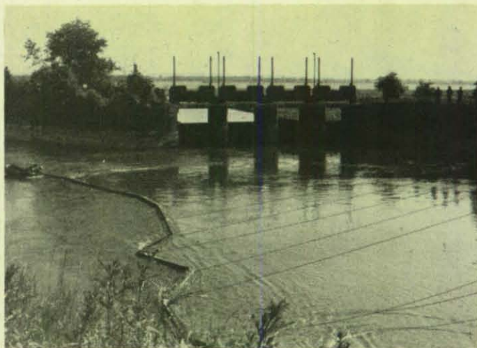
Die Ölsperre ist mit Leinen in Position gebracht. (Foto: Lehmann)
