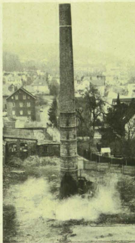
Auf den Meter genau läßt sich der Kamin durch die gerichtete Sprengung legen. (Foto: Franz)
