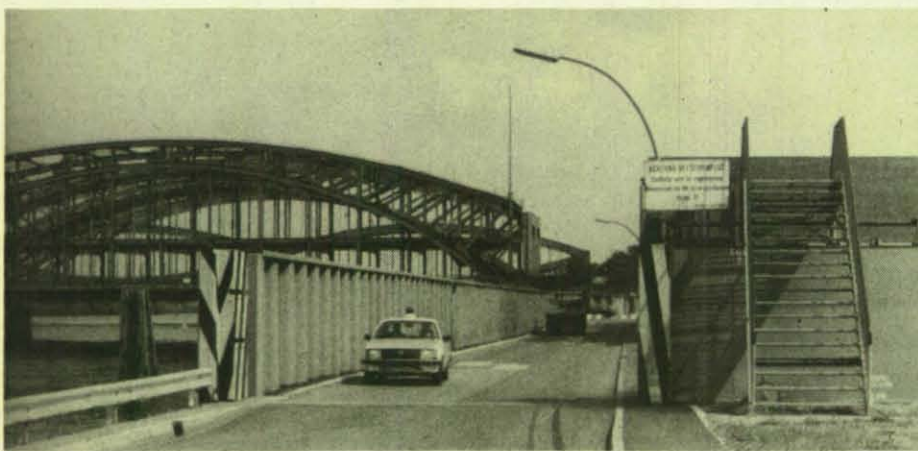
Im Hafen: Die Polderwände sind deutlich neben dem Feuerwehr-Fahrzeug zu erkennen.
