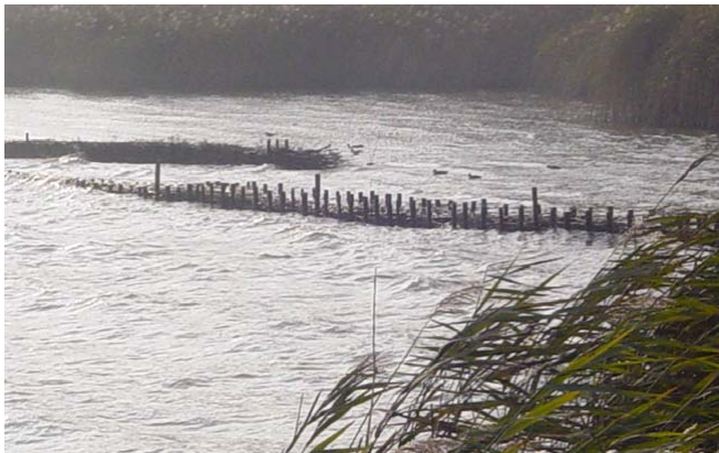
Abbildung 3: Wellendämpfende Wirkung von Lahnungen
