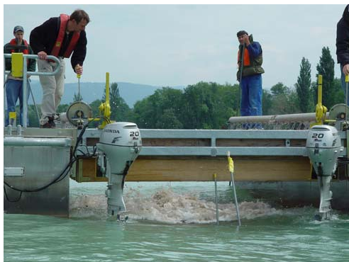
Abb. 6: Sutz-Lattrigen - Hauptstation. Erosionsschutzmassnahmen 2003-2004. Verklappen einer Kiesladung.
