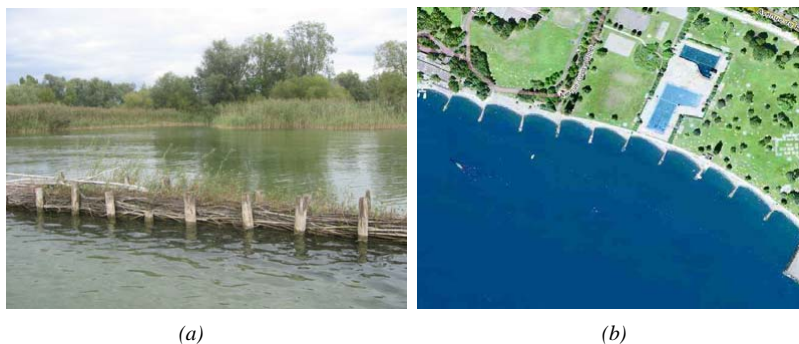
Figure 1 : Protection des rives par des mesures souples : (a) protection des roselières par des barrages à claire-voie sur le lac de Biemme; (b) stabilisation par matériaux fins et épis à la Bellerive sur la rive nord du Léman
