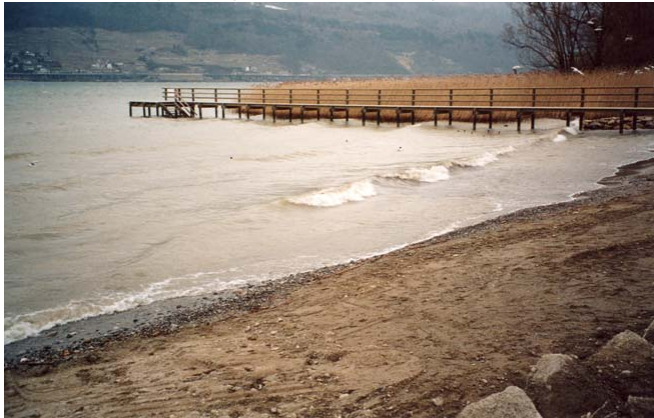
Abb.4: Je seichter die Flachwasserzone und je geringer die Schüttneigung, desto feineres Material kann geschüttet werden.
