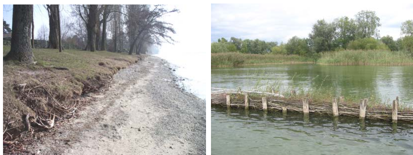
Figure 1 : à gauche, érosion linéaire sur la rive nord du Léman; à droite, Protection de rive par des barrages à claire-voie sur le lac de Biemme
