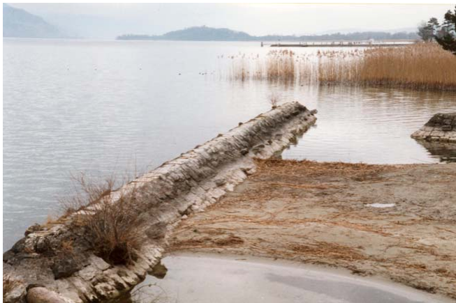
Abb. 2: Durch Refraktion der Wellen am Wellenbrecher (links) bildet sich ein Tombolo (rechts)
