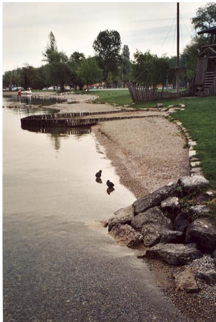
Abb. 5: Die Verjüngung der Böschungsbreite gegen den Vordergrund hin hat eine übersteilen Böschungsneigung, zur Folge. Die Kiesschüttung wird durch die Brandung jedoch abgeflacht, was zu einem Verlust von Material durch seitliche Verfrachtung in Richtung des Betrachters oder zu einer Unterspülung der Blockreihe an der Böschungsoberkante führt.
