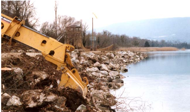
Abbildung 4: Rückbau eines Blockwurfs (Strandbad Erlach)
