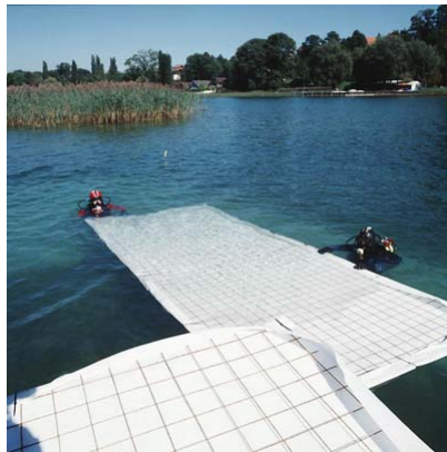
Abb. 2: Sutz-Lattrigen - Hauptstation. Erosionsschutzmassnahmen 2000-2001. Verlegen der Stahlgittermatten vom Arbeitsboot aus. Etwa 25 Gittermatten können in einem Arbeitsgang von etwa 2 Stunden ausgebracht werden.
