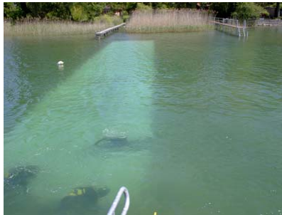
Abb. 4: Sutz-Lattrigen - Hauptstation. Erosionsschutzmassnahmen 2003-2004. Eine ausgerollte Bahn Geotextil von 30 x 5 m zeichnet sich vom dunkleren Seegrund ab. Für das Verlegen sind mindestens zwei Taucher im Einsatz.
