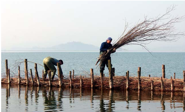
Abbildung 3: Bau einer Lahnung zum Schutz von Schilfbeständen (Mörigen)
