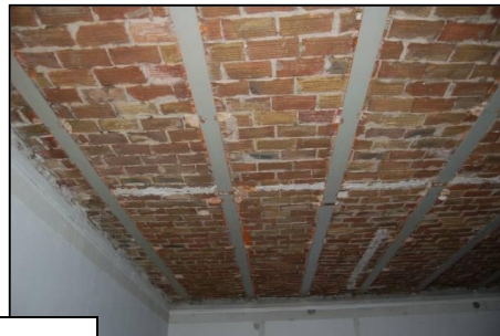
Bild 20: Untersicht einer Försterdecke
