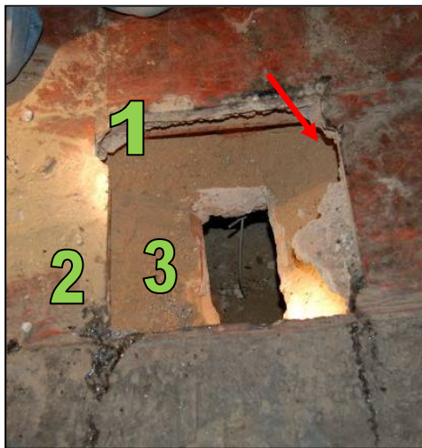
Bild 19: Aufbau einer Försterdecke, 1 Plattenbelag und Estrich (1), Walzträger (Obergurt) (2) Steindecke (3), Spalt mit entferntere Sandfüllung, siehe Pfeil
