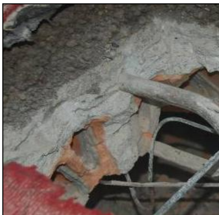
Bild 25: Im Bereich Endauflager geöffnete Kaiserdecke, vergleiche Bild 22
