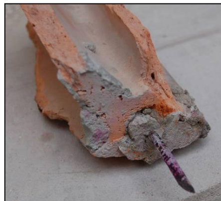
Bild 25: Vergusskanal des Systemsteins Kaiserdecke, vergleiche Bild 22 und 25
