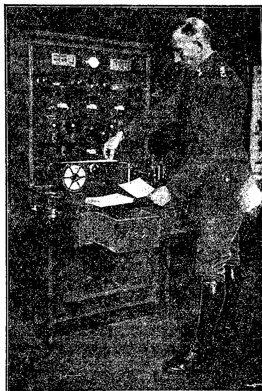
Entgegennahme des Hilferufs in der Zentrale
