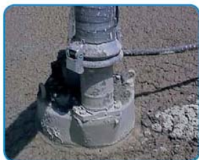
EL10S: Verpumpen von Schlamm aus Tunnelbaustelle
