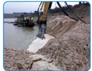
HY85B + 2 EXHY20: Einsatz im Baggersee
