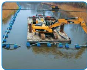
HY85B: Einsatz in Flussanierung
