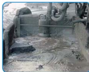
EL12,5: Pumpen von Schlammigem Schmutzwasser aus Reifenwaschanlage
