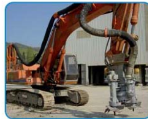
HY85B + EXHY20 in Verbindung mit Hitachi FH-300 Raupenbagger
