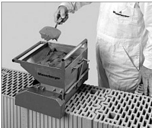
*Befüllen der VD-Mörtelwalze mit dem VD-Dünnbettmörtel*
