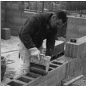
Versetzen der weiteren SBZ Planziegel durch Aufbringen des Dünnbettmörtels mit der Auftragswalze.
