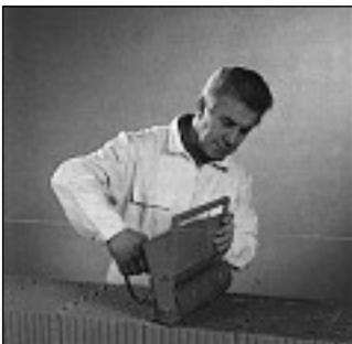
Ab der 2. Schar werden die POROTHERM Planziegel mit dem mitgelieferten POROTHERM Dünnbettmörtel verarbeitet. Der POROTHERM Dünnbettmörtel wird nach der auf dem Mörtelsack aufgedruckten Gebrauchsanleitung angesetzt. Zum Anrühren des Mörtels
