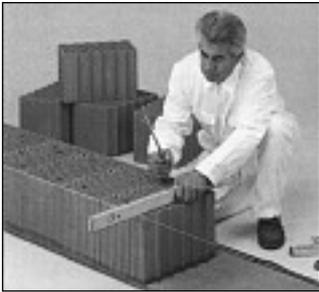
Die erste Ziegelschar wird, von den Ecken beginnend, nach Schnur verlegt. Im Regelfall kann die erste Schar unmittelbar in das Kalkzement-Mörtelbett versetzt werden, wobei jedoch darauf geachtet werden muss, dass der Mörtel eine ausreichende
