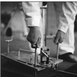
Eine stabile Abziehlatte (am besten Alu mit 3–4 m Länge), die auf den Peiler der beiden Nivellier-Max-Geräte aufgesetzt wird, dient dazu, dass beim Auftragen des Mörtels kein Material über den Rand der Decke hinausfällt. Nun wird zwischen den beiden Nivellier-Max-Geräten im Bereich des zu erstellenden Mauerwerks ausreichend Mörtel auf den vorbereiteten Untergrund aufgebracht. Jetzt nehmen zwei Mann die Abziehlatte und ziehen sie langsam über die Peiler der beiden Nivellier-
