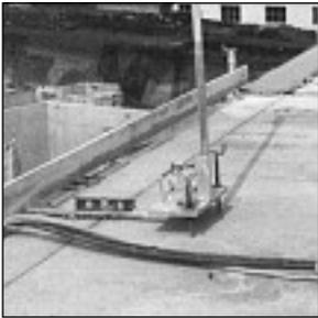
Anlegen der Ausgleichsschicht mit Anlegemörtel sowie mit den Hilfsgeräten Nivellier-Max und Nivellierlaser.
