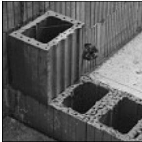
Versetzen der ersten Schar in den Anlegemörtel und Ausrichten mit Wasserwaage.
