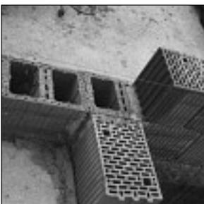
Eckverbände und Wandanschlüsse werden in Stumpfstoßtechnik mit Flachstahlanker ausgeführt ...
