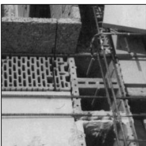
Anbringen der Deckenbewehrung über den Kammern der SBZ Planziegel.
