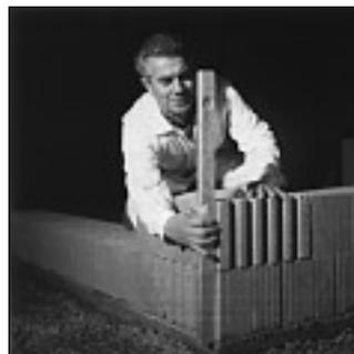
Mit Wasserwaage und Gummihammer werden die Eckziegel exakt ausgerichtet, die Maurerschnur gespannt und die erste Schar Ziegel um Ziegel knirsch gesetzt.
