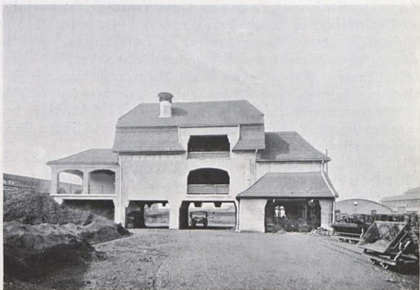
Schlackenbrech- und Sortieranlage.
