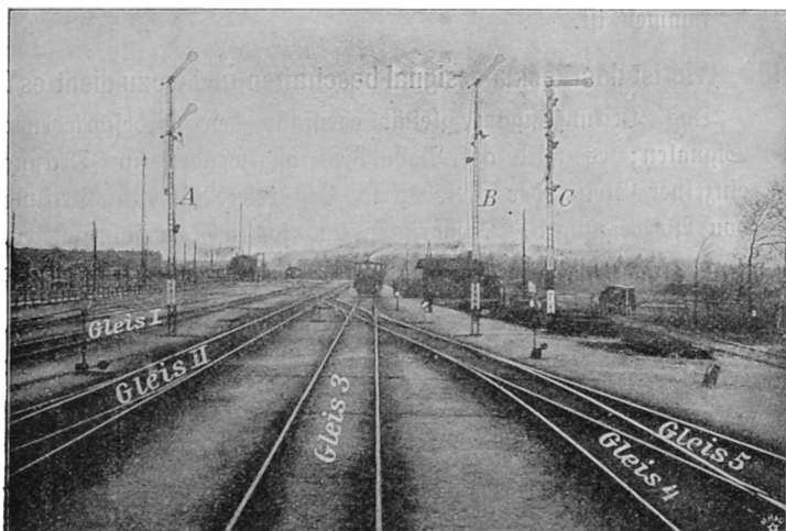
Ausfahrtsignale der Westseite des Bahnhofes Koblfurt.
