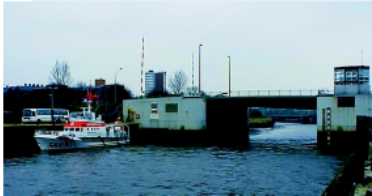
Sturmflutsperrwerk an der Geeste
