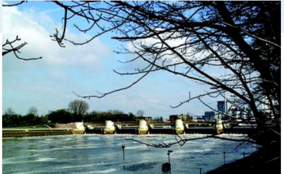
Neues Weserwehr (in Betrieb seit 1. April 1993)
