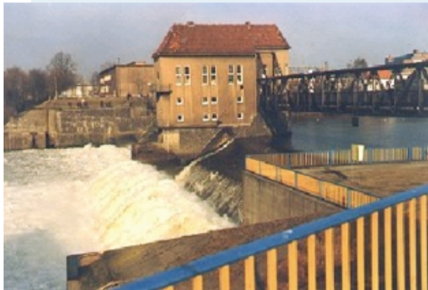
Das alte Weserwehr in Bremen-Hemelingen (in Betrieb bis 1993)
