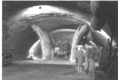
Abbildung 8-11 Ulmenstollenvortrieb (nach Braun & Wenner, 1999)
