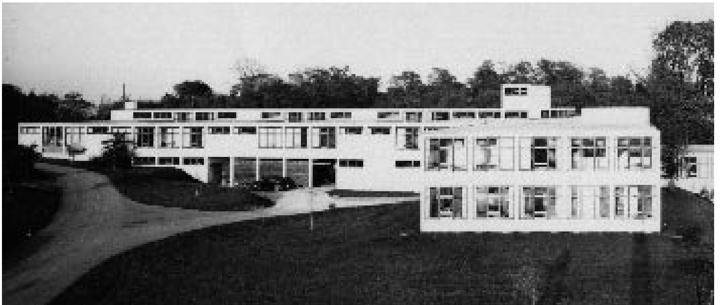
Abb. 36 Ansicht hfg Ulm Blick von Westen
