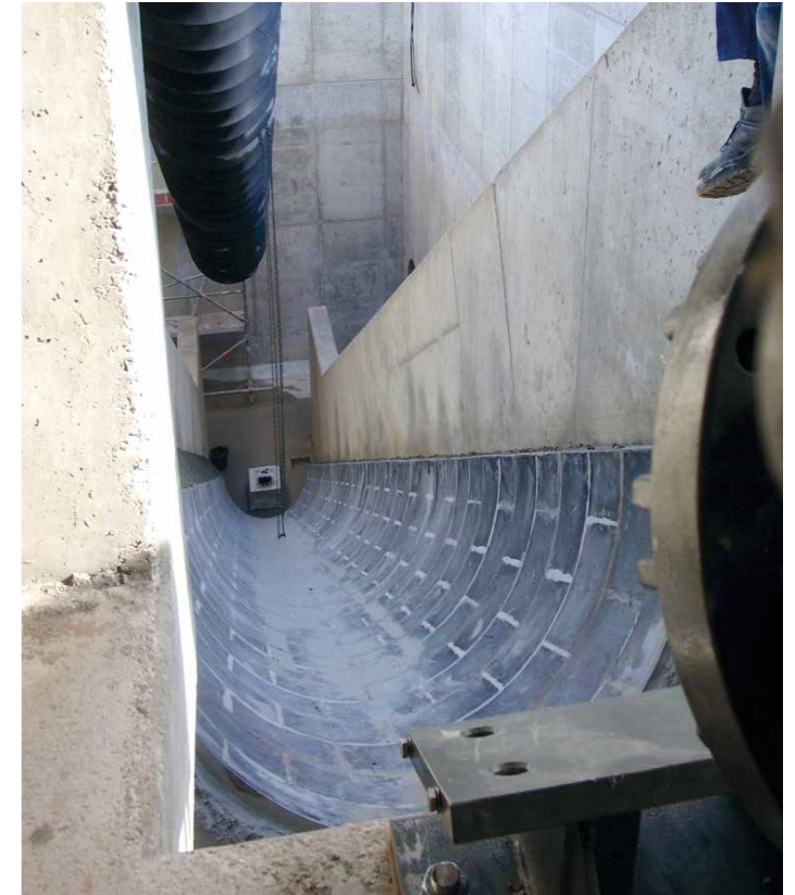
Saniertes Schneckenbett vor Einbau der Förderschnecke
