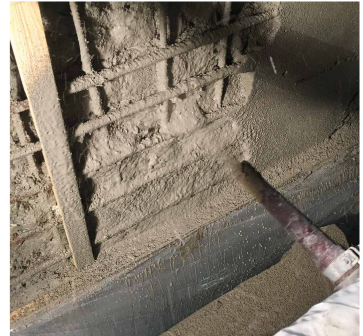
Abwasserbauwerk mit Beschichtungsmörtel SC-AwaTec® repro
