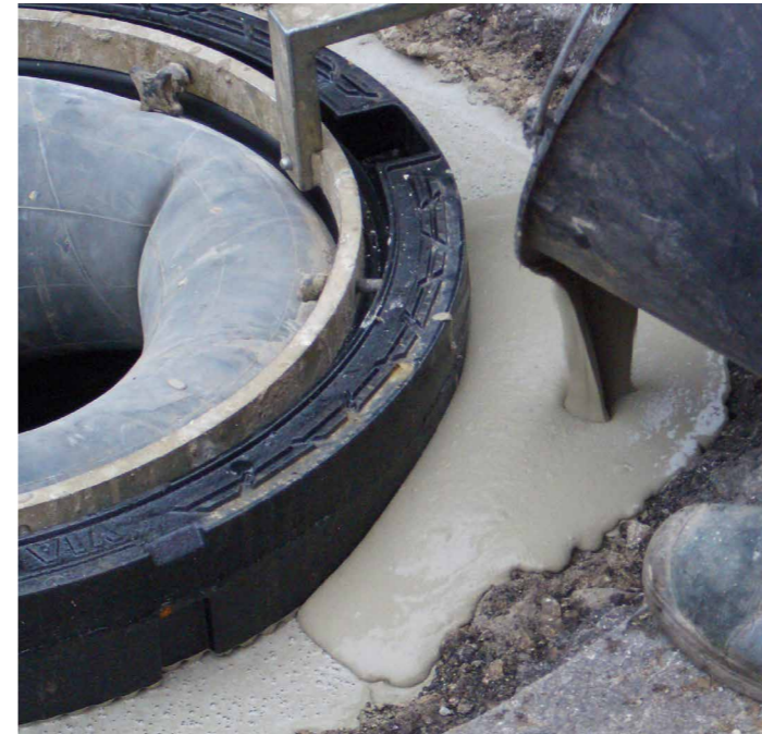
Einfassung mit Schachtkopfmörtel SC-AwaTec® supix
