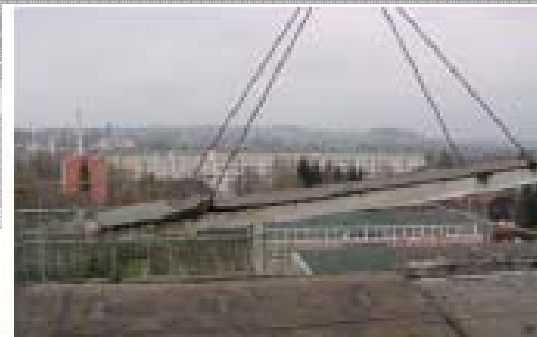
Demontage der Dachkassettenplatten
