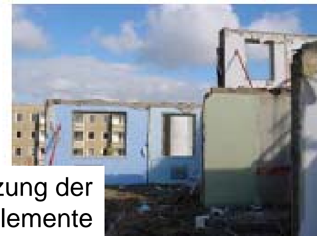
Demontage der Geschossdecken
