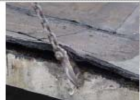
Demontage der Dachkassettenplatten
