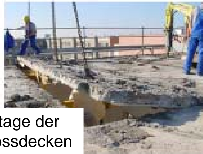
Demontage der Dachkassettenplatten
