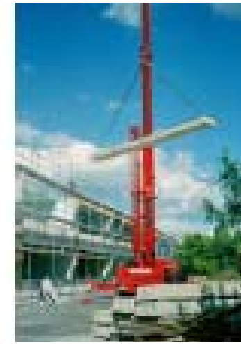
Demontage der Dachkassettenplatten
