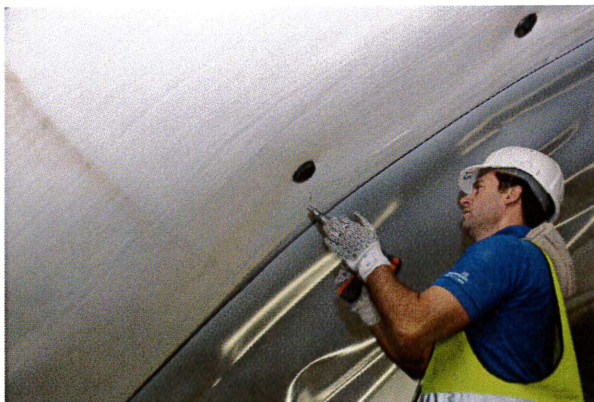
Abbildung 6: Befestigung Schutzvlies
