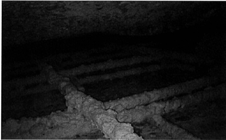
Abbildung 9: Beispiel für freiliegende Bewehrung 3
