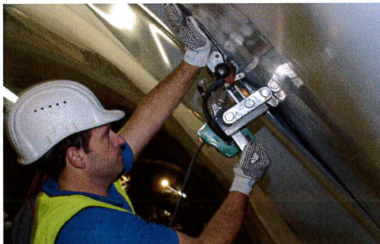
Abbildung 8: Schweißung und Prüfung
