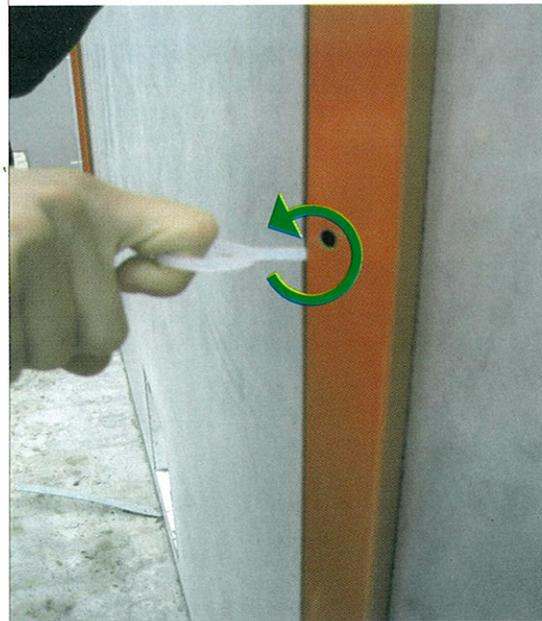
Achtung: Vor dem Betonieren den festen und korrekten Sitz der Schiene überprüfen!
