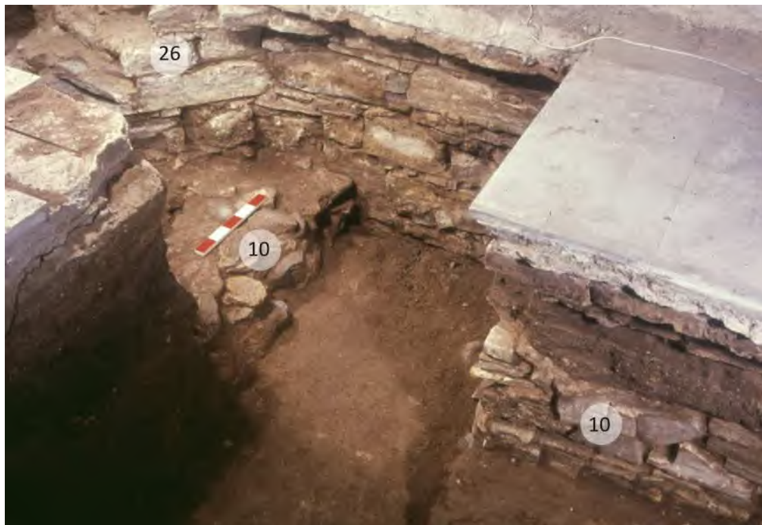
Abb.6: St. Magnus Everswinkel. Die Fundamente des Baus II (10) im Chor. Deutlich höher ansetzend gotischer Chorabschluss (26) des bestehenden Baus (Bau III). Blick nach Süden (Foto: J. F. Jüttner).
