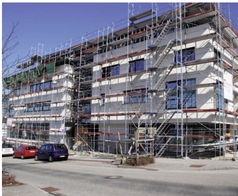
Das Haus der Chemie-Verbände kurz vor der Fertigstellung.
