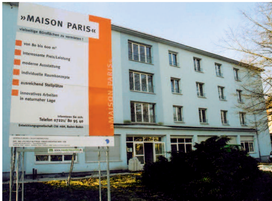
Die Heimat von „La Cité“: Das neue Maison Paris in seiner Entstehung.
