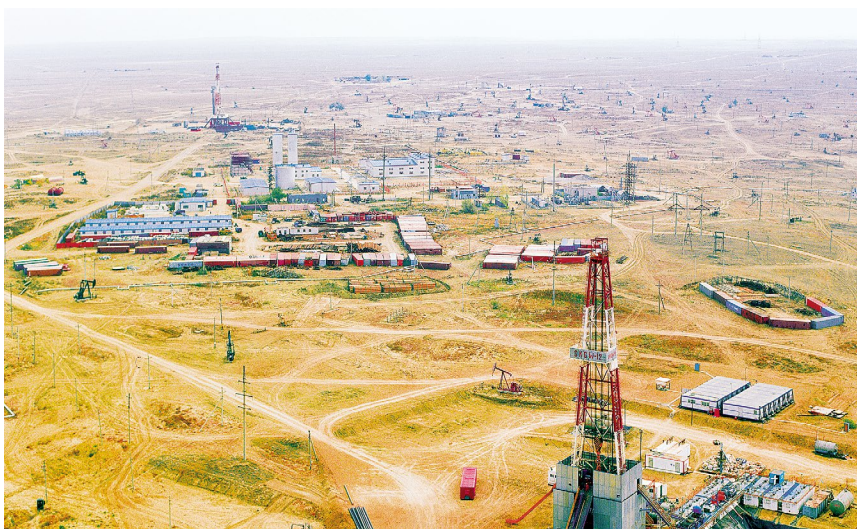
阿克纠宾项目钻井现场
