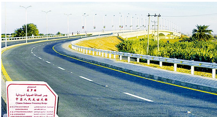
中国石油捐资助建的苏丹麦罗维友谊大桥
