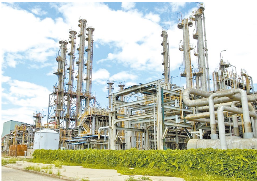
东方化工厂拆除前原貌
