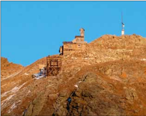
Abb. 16: Schneeberg/Moos in Passeier. Eisenkonstruktion des Durchschlagstollens für die Materialseilbahn im Bereich der Schneebergscharte (Hinterwaldner/Holdermann 2012).
