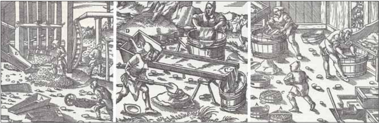
Abb. 17: Prozesse der Erzaufbereitung um das Jahr 1556. von links nach rechts: Pochwerk mit vier Pochstempeln, Erzaschen mit dem Planen-Herd, manuelles Stauchsetzen (Agricola 1556).
