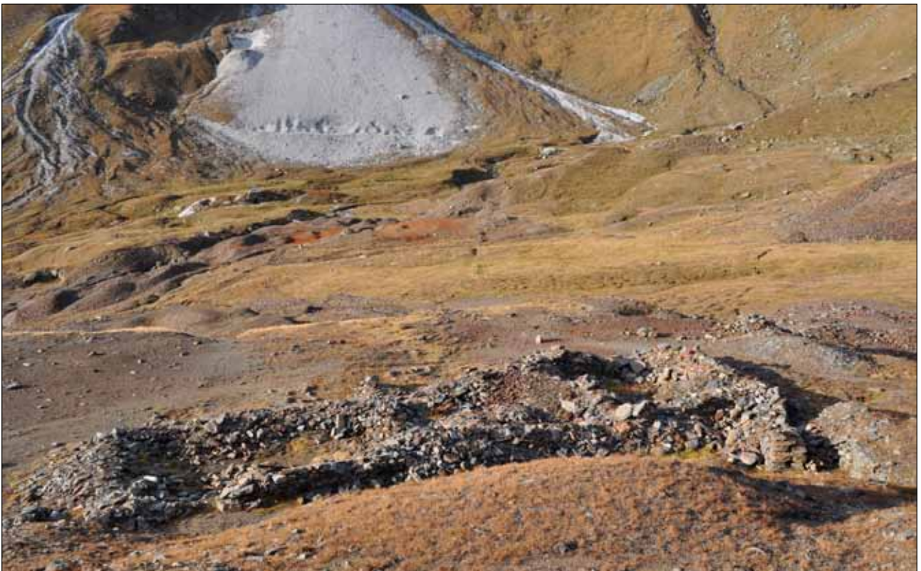
Abb. 8: Schneeberg/Moos in Passeier. Die St. Gallen-Kaue (Blick von Osten). An ihrer rechten Flanke der Schneekragen des St. Gallen-Stollens. Davor in der Bildmitte der St. Gallen-Pocher, links dahinter der sanierte Kalkofen (Foto: Hinterwaldner/Holdermann 2010).
