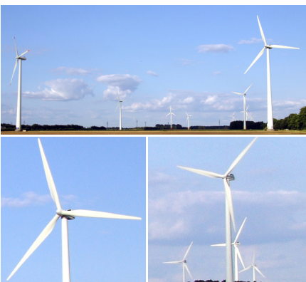
Windräder bei Ehlershausen. Sie sollen wie andere bestehende Anlagen durch 200 Meter hohe Windflügel ersetzt werden.
