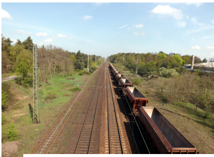
Die Bahngleise führen gerade einmal 50 Meter an den Wasserbrunnen vorbei. Früher setzte hier die Bahn das Nervengift Ethidimuron gegen unerwünschte Pflanzen ein.
