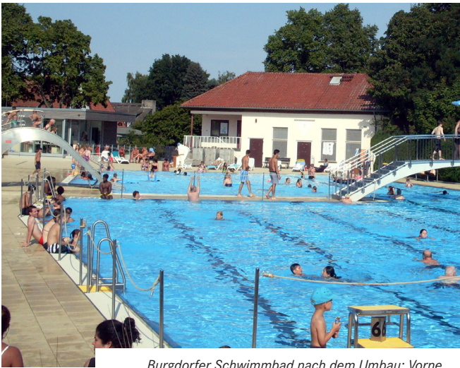
Burgdorfer Schwimmbad nach dem Umbau: Vorne das enorm verkleinerte Schwimmbecken und dahinter der Nichtschwimmerbereich mit Wasserrutsche, für den es früher ein eigenes Schwimmbecken gab.
