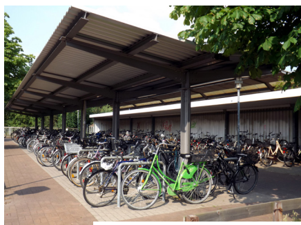
Radabstellanlage auf der Westseite des Bahnhofs.
