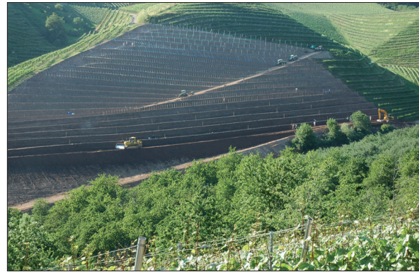
Abb. 11: Lierenbach während den Planiearbeiten: Im Hang wird die Wegeführung geändert, damit von den Querterrassen direkt auf den schräg verlaufenden Weg gefahren werden kann.
