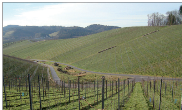
Abb. 9: Westseite nach den Planiearbeiten, fertig bepflanzt, Inklination < 35 %
