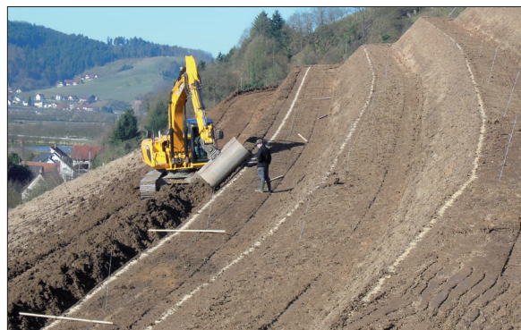
Abb. 7: Abziehen Böschung mit Hilfe des Baggers
