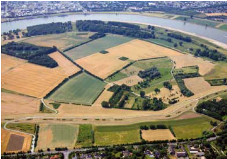
Abbildung 14: Luftbild des Retentionsraumes Langel; Quelle (Stadtentwässerungsbetriebe Köln, AöR, 2008, S. 39)
