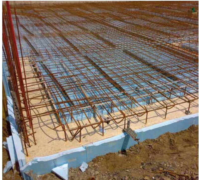
Bild 25: Perimetergedämmte Fundamente mit Erdfähigkeit
