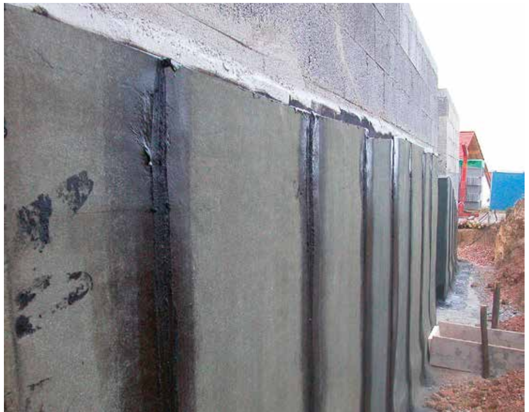
Bild 22: Ausführungsbeispiel einer „schwarzen Wanne“ mit Bitumen-Schweißbahnen
