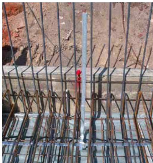
Bild 18: Waagrecht verlegter Fundamenterder in der Fundamentbewehrung
