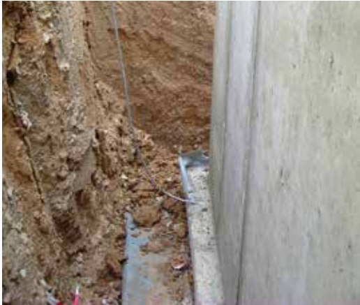
Bild 10: Ausführungsbeispiel einer Anschlussfahne aus Edelstahl (V4A)
