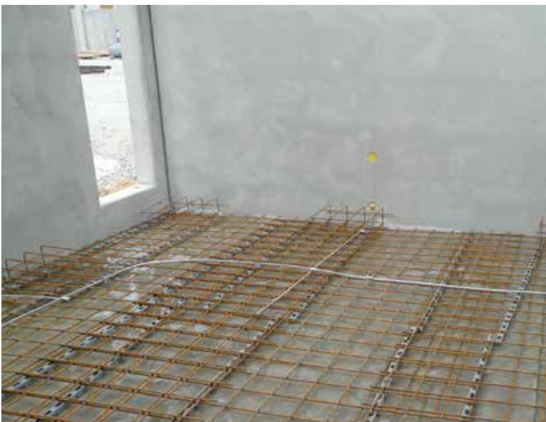
Bild 7: Beispiel für die Ausführung des Funktionspotentialausgleichsleiters
