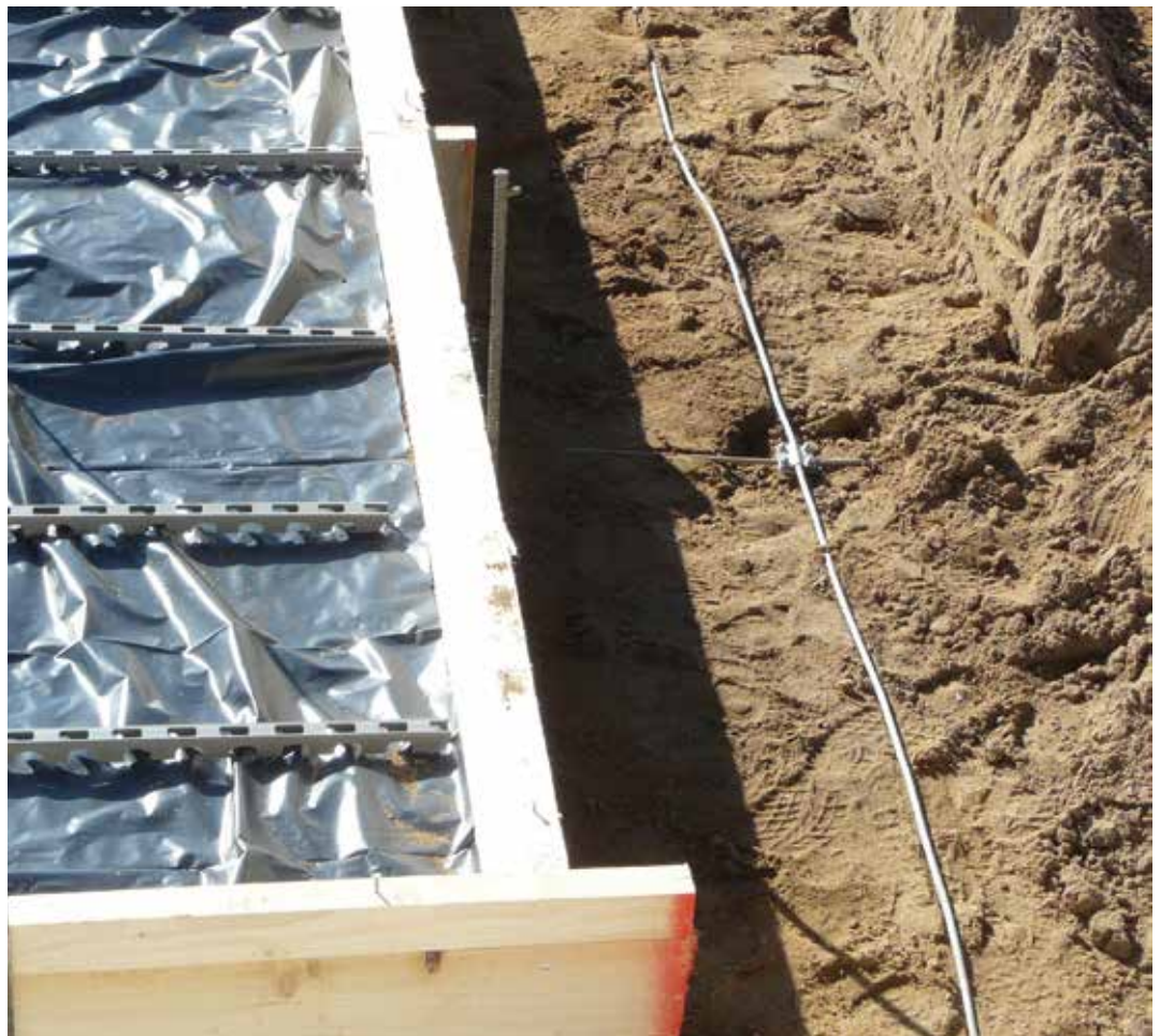
Bild 6: Beispiel für die Ausführung eines Ringerders
