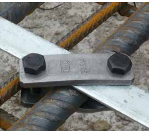
Bild 12: Schraubverbinder für Bandstahl
