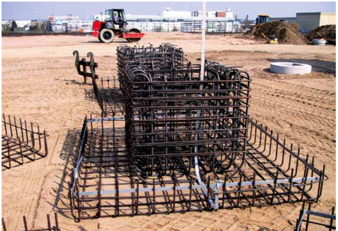
Bild 19: Fundamenterder und Anschlussfahne bei einem Einzelfundament
