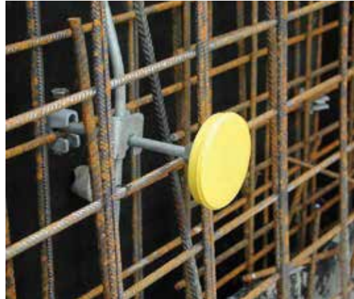
Bild 11: Erdungsfestpunkt
