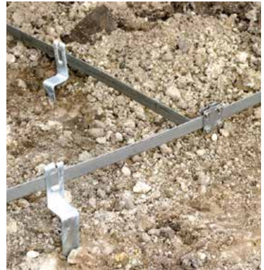
Bild 15: Abstandhalter montiert in der Fundamentsohle
