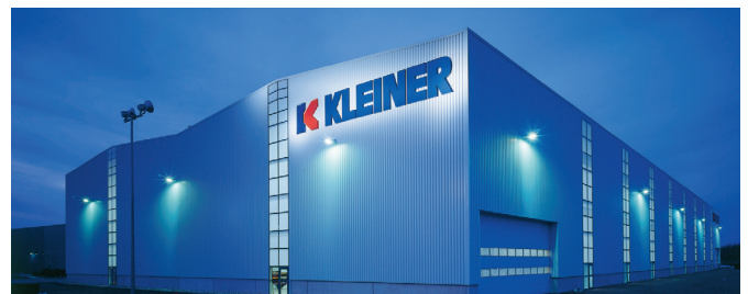
Abbildung: Stahlhalle bei Nacht
