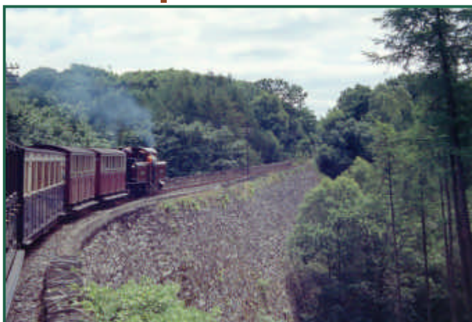
Der Zug quert den mit 62 Fuß (ca. 20 m) hohen steinernen Damm "Ceï Mawr", den höchsten auf der Strecke.
