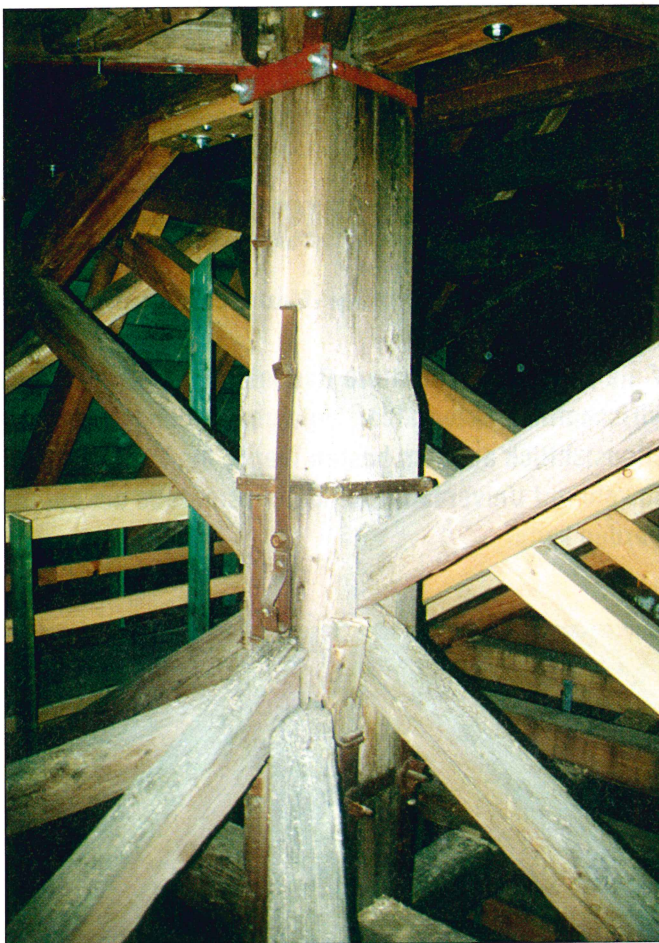
Kaiserstiel im Einbauzustand
