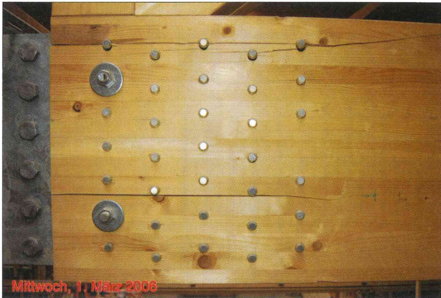
Bild 11: Tragfähigkeitsmindernde Rissbildung im Bereich von Stabdübelverbindungen eines Zugstoßes (Stabkraft: {}_{\text{vorh}}N_{t,d} = 1230 \text{ kN} )
