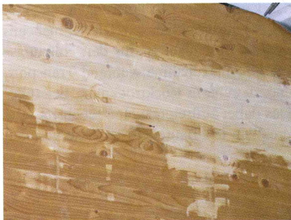
Bild 13: Rissanierung, ausgetretener Klebstoff wurde mittels Schleifmaschine entfernt und die Holzoberfläche sauber abgeschliffen
