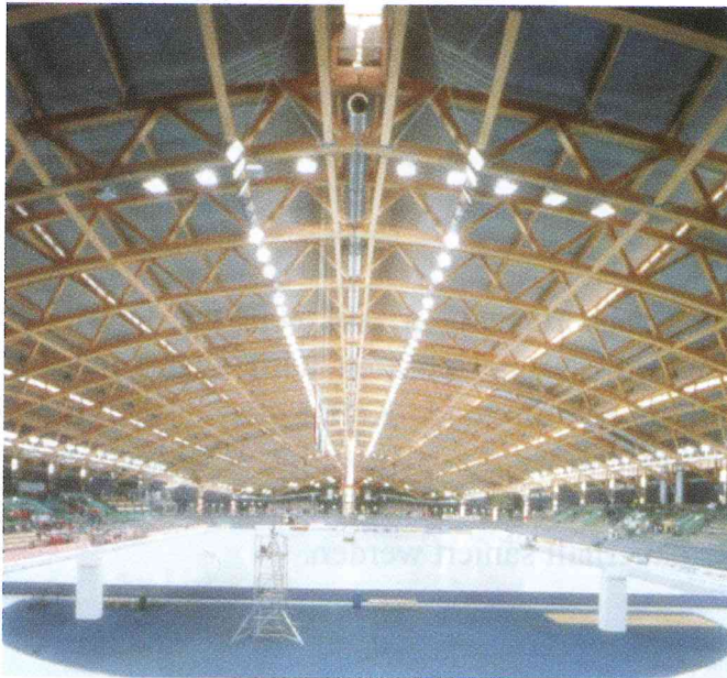
Bild 1: Olympiahalle Hamar/Norwegen, Zweigenk-Fachwerkrahmen aus Brettschichtholz mit maximaler Spannweite von 96 m, Hallenlänge 260 m (Foto: Arge Holz Düsseldorf)
