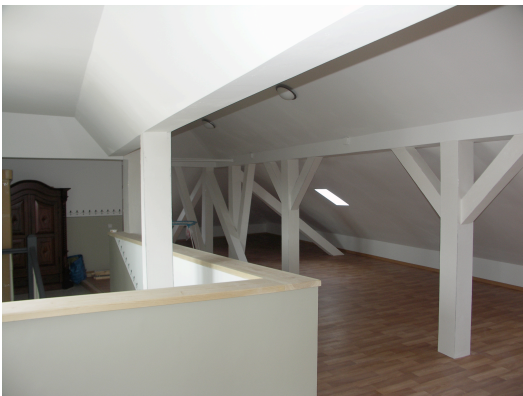
Bild 6: Brandschutztechnische Verkleidung freiliegender Holzbauteile im Dachgeschoss eines mehrgeschossigen Wohnhauses (Anforderung F30-B)
