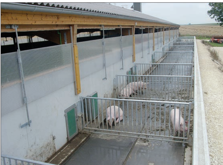
Auf beiden Längsseiten sind planbefestigte Ausläufe mit Schieberentmistung.
