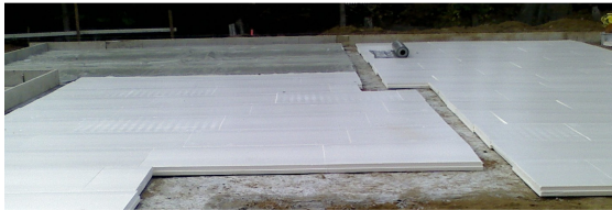
Foto: Kleiske Styrodur/60 mm + 2 x PE-Folie/0,16 mm
