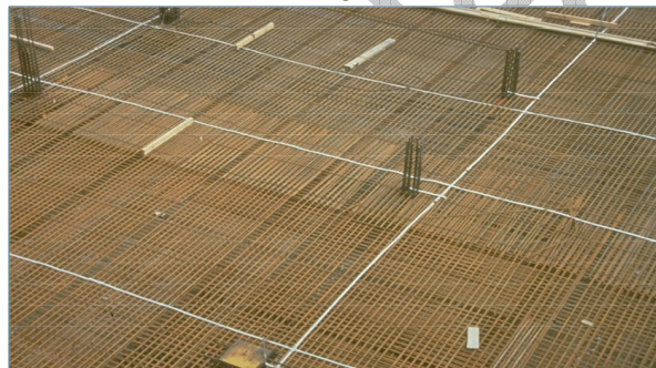
Grafik: Kleiske Fundamenterderkorb mit Anschlussfahnen
