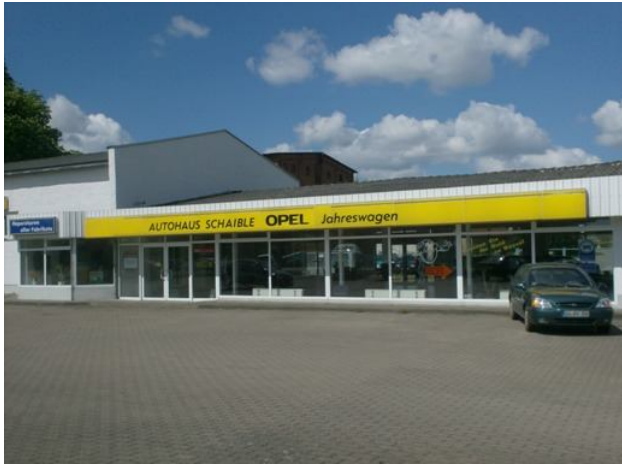
Das Autohaus in 18276 Prüzen wird bis heute als Opel-Autohaus betrieben und befindet sich in einem guten baulichen und optischen Zustand
