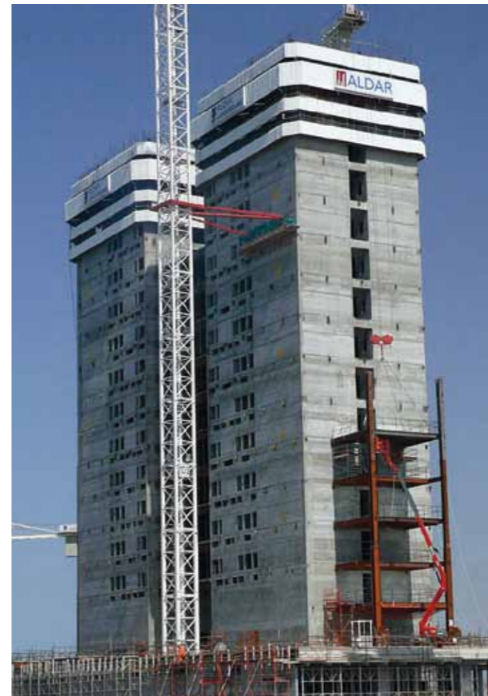
Betonierte Turmkerne und letztendliche Form des Aldar Headquarters in Abu Dhabi
