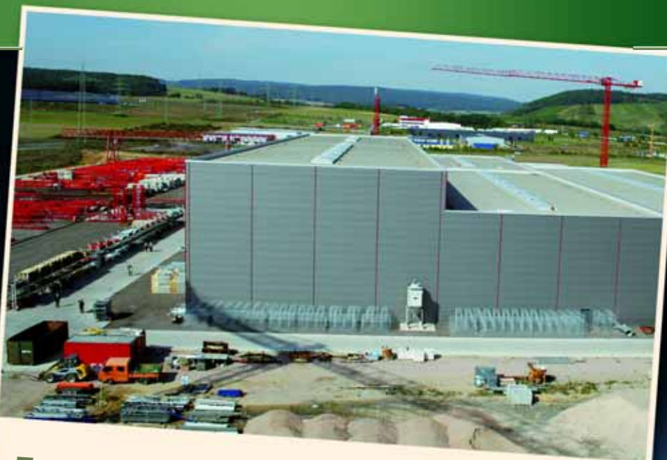
▲ VOGELPERSPEKTIVE Das neue Werksgelände vom Kranausleger aus gesehen.
