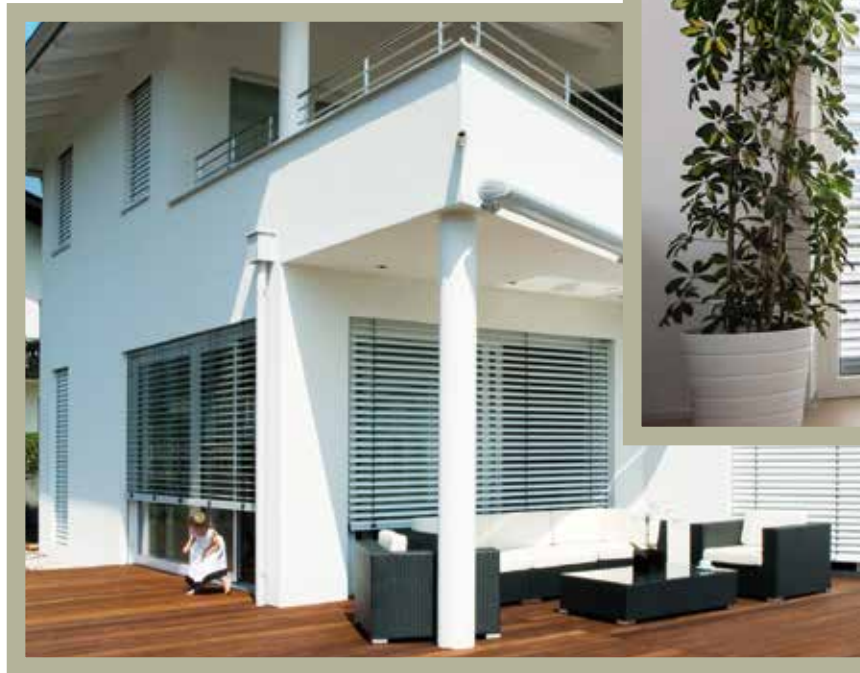
Außenliegende Beschattung wirkt laut Actual rund acht mal effizienter als innenliegender Sonnenschutz und rund doppelt so effizient wie scheinintegrierter Sonnenschutz.
