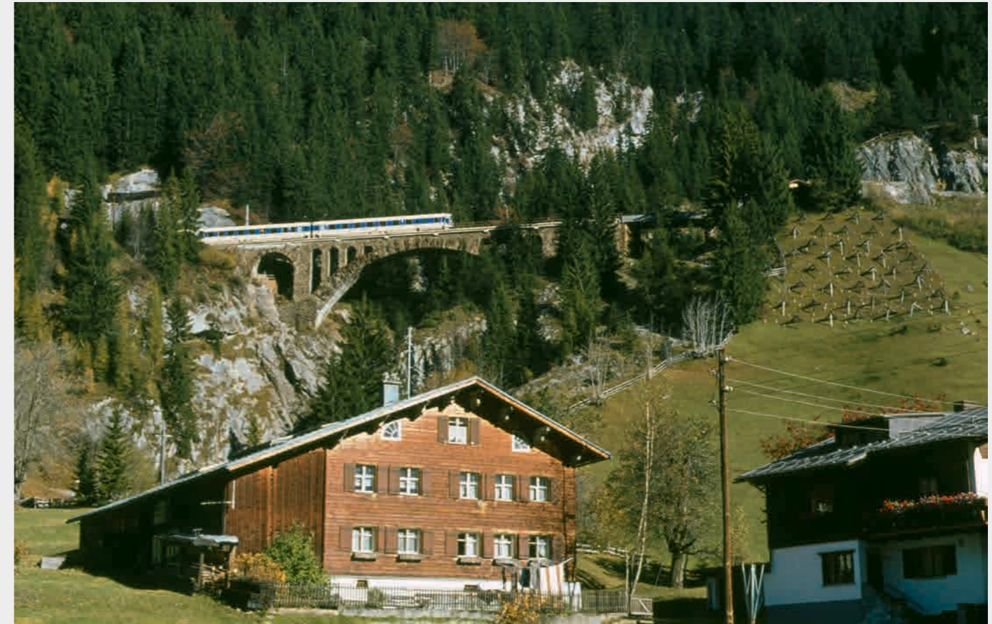
Und hier die Szenerie vom Talboden aus beobachtet: Mit einem Steuerwagen voraus fährt ein 4010-Triebwagen auf dem Wälditobelviadukt Langen am Arlberg entgegen. Auf der linken Seite lag die Haltestelle Klösterle. Hier war gute Kondition nötig, um dorthin zu gelangen. Heute führt die Bahn in diesem Bereich durch den zweigleisigen Blisadonatunnel. (Foto: Walter Schögl, Archiv PBV)
