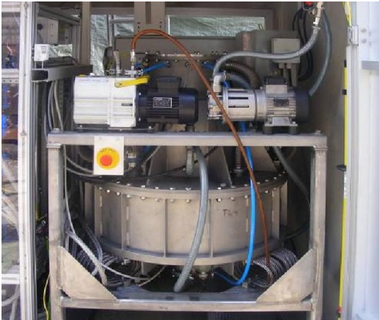
Abb. 17: Der Speicher T2 im Speicherwerk Bremen, vorn oben zu sehen ist die Drehkolben-Vakuumpumpe und die Kühlwasserpumpe
