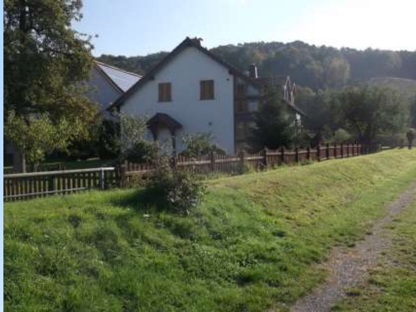
A01 – Deich südlich Argenstein
