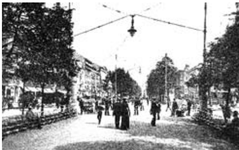
Abb.5 Mittelpromenade vor dem Umbau, 1902, Landesbildstelle Berlin
